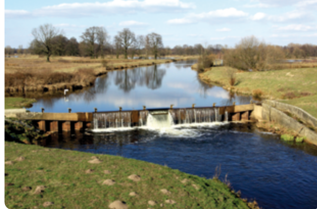
Durch ein Überlaufwehr in der Ems wird Wasser in das „Steinhorster Becken“ flach eingestaut. Hier kann der Wasserstand reguliert werden.
